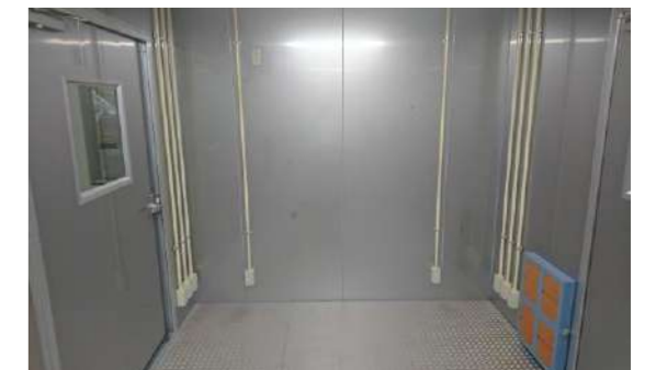
測定室から見た試験室内
